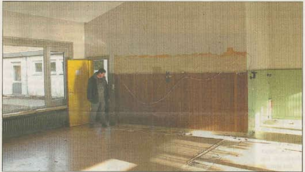
Ein Bewohner des Hauses Elm besucht vor dem Umbau noch einmal die alten Räume. In den Fluren sind die Holzverkleidungen an den Wänden bereits entfernt worden.
